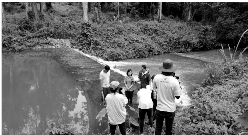
รูปที่ 5 บริเวณฝายหินทิ้งสำหรับดักดินตะกอน (ถ่ายเมื่อ 7 ตุลาคม 2558 พิกัด GPS: 47P 049264, UTM 1651854) (ภาพโดย สุพัฒน์ ปลื้มปัญญา)
