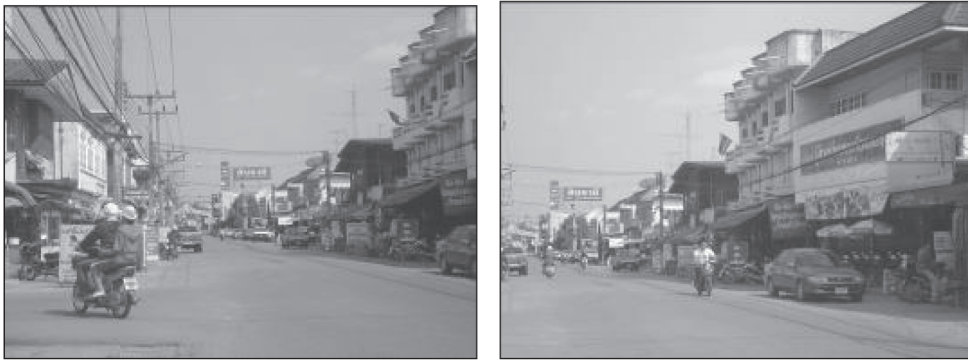
รูปภาพที่ 6 สภาพอาคารของชุมชนปง บนถนนสายขุนยม (ถนนสายหลักของเมือง)
