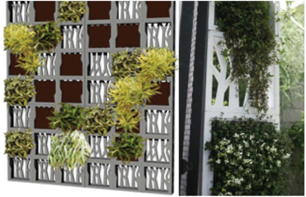
ข. สวนแนวตั้งแบบใช้อิฐมวลเบาเป็นช่องปลูก
