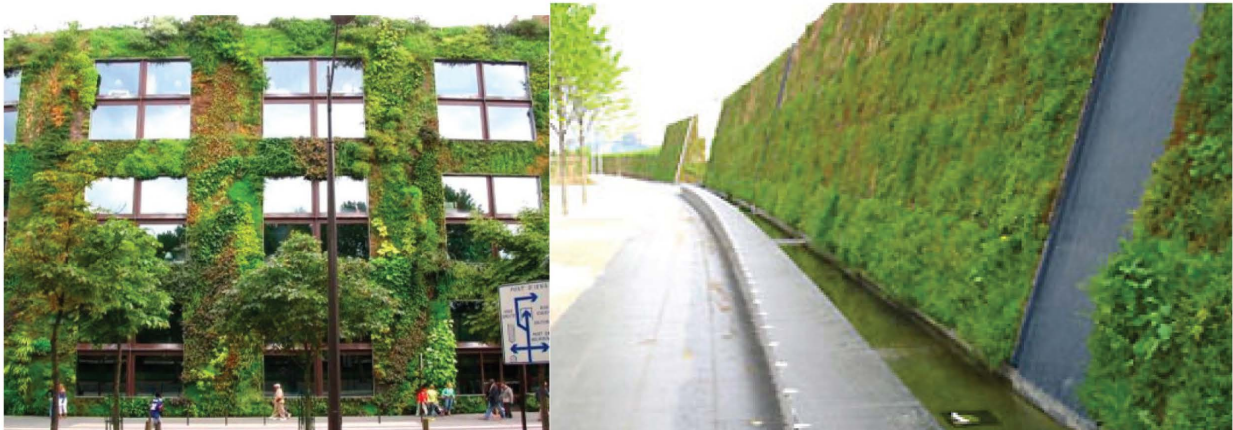
รูปภาพที่ 3 สวนแนวตั้งแบบผนังโดยใช้แผ่น Felt
