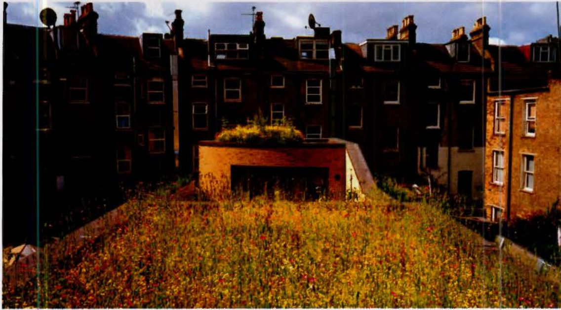
ภาพ สวนดอกไม้บนหลังคาบ้าน จัสติน เบียร์ สถาปนิกที่สร้างบ้านตัวเองเป็นบ้านพลังแสงอาทิตย์ สวนนี้ช่วยลดพลังงานที่ต้องใช้ในเครื่องปรับอากาศได้เป็นอย่างดี
