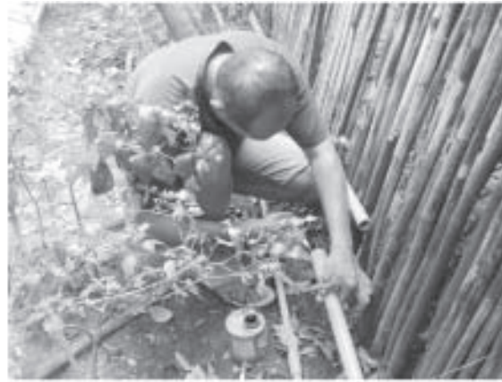
ภาพที่ 4 แสดงภาพบ่อก๊าซชีวภาพและการต่อท่อก๊าซชีวภาพไปยังชุมชน
