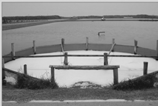
ระบบบำบัดน้ำเสีย
