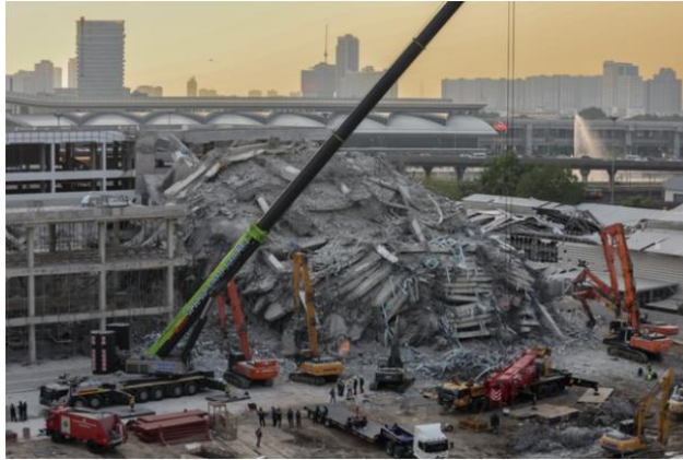
รูปที่ 4B อาคารของสำนักงานตรวจเงินแผ่นดิน กรุงเทพมหานคร
